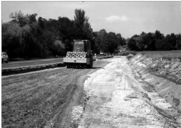
Foto 5. Mediante la estabilización química de un suelo arcilloso, de baja capacidad portante se consigue elevar su CBR hasta permitir su empleo como sub-rasante en carreteras.
