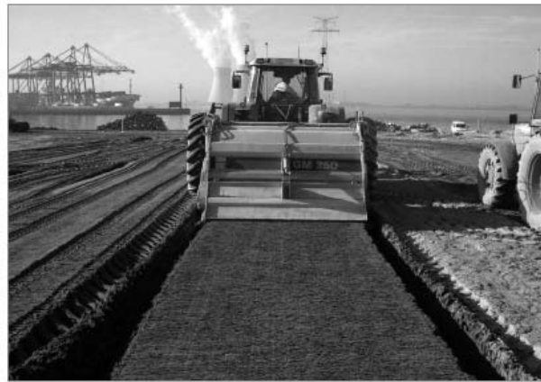
Foto 4. El empleo del aditivo sobre el suelo A-2-7(0) mejoró significativamente sus propiedades mecánicas y aumentó apreciablemente su resistencia ante los efectos del agua.
