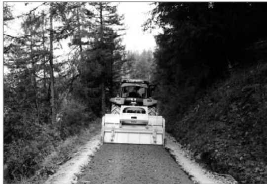
Foto 1. Desde hace varios años se realiza en Cuba una investigación para conseguir estabilizar suelos con sales cuaternarias de amonio, buscando incrementar su resistencia y reducir su permeabilidad.
