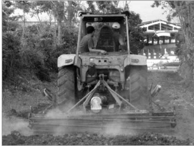
Foto 2. La incorporación del aditivo a una arena uniforme de tipo A-2-7, conteniendo arcilla de alta plasticidad, consiguió un producto apto para su empleo en subrasante de tráfico pesado.
